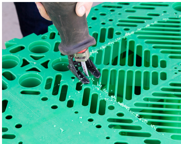
Joonis 11. Ava saagimine adapteri jaoks
